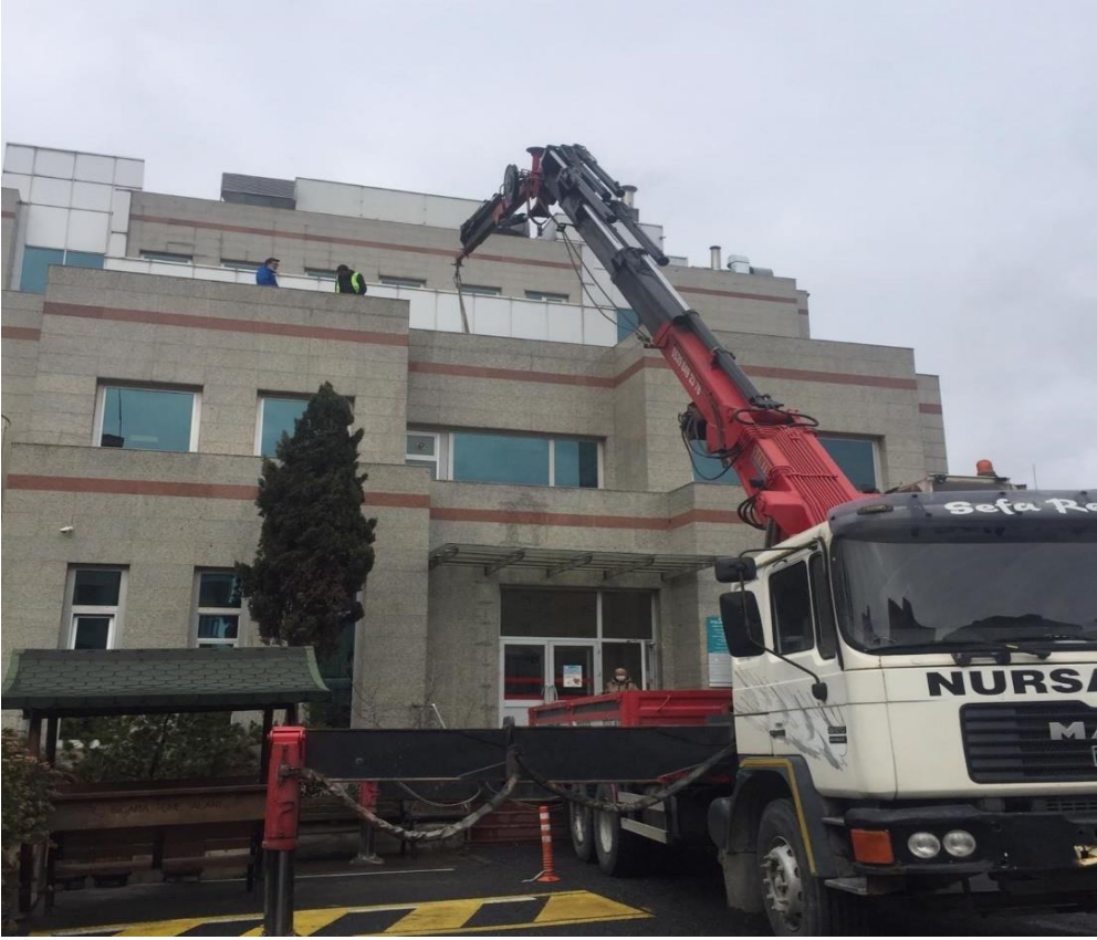
Fotoğraf 9. PV Panellerin Çatıya Taşınması-Örnek
