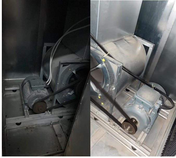
Fotoğraf 6. Vantilatör ve Aspiratör Motorları
