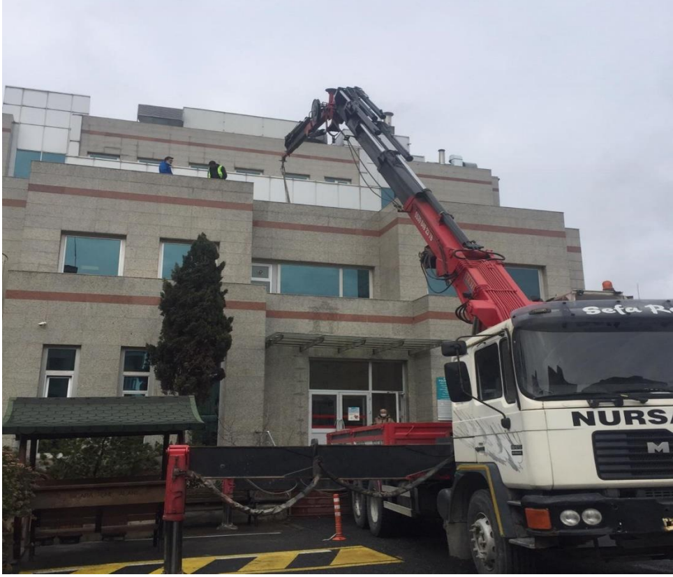
Fotoğraf 8. PV Panellerin Çatıya Taşınması-Örnek
