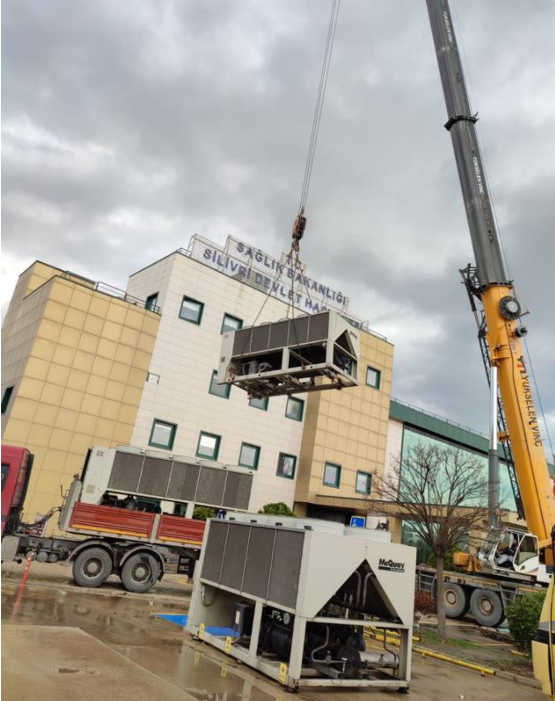
Fotoğraf 10. Mekanik Cihazların Mobil Vinç ile Çatıya Taşınması Örnek 1
