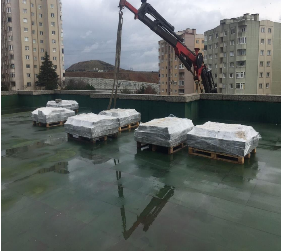
Fotoğraf 9. PV Panellerin Çatıya Taşınması Örnek-2
