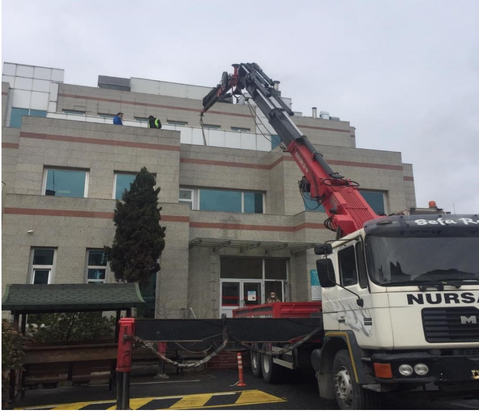
Fotoğraf 8. PV Panellerin Çatıya Taşınması Örnek-1
