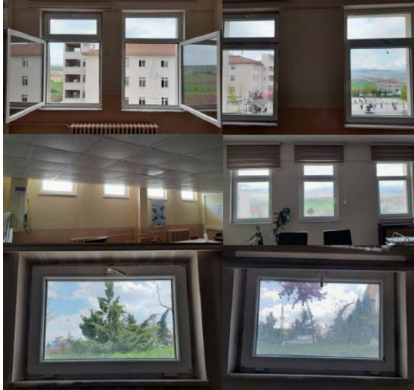
Fotoğraf 4. Vezirköprü Hatice Kemal Kayalıoğlu Fen Lisesi Binası Pencere Örneği
