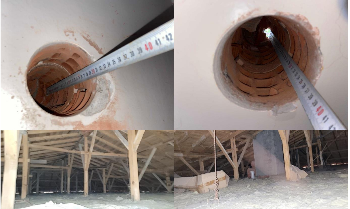
Fotoğraf 6. Bafra Kız Anadolu İmam Hatip Lisesi Okul ve Pansiyon Binaları Yalıtım Görünüm Örnekleri
