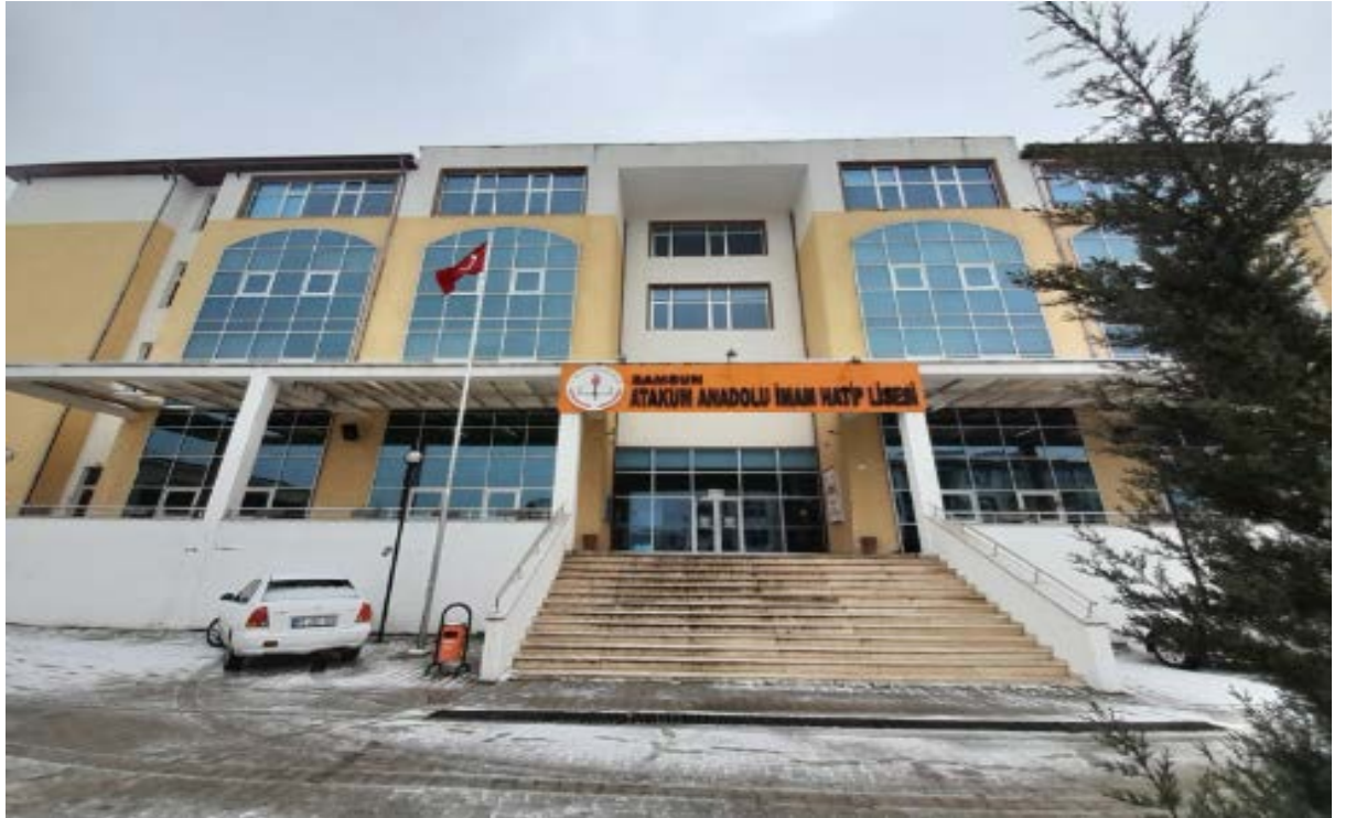
Fotoğraf 2. Atakum Anadolu İmam Hatip Lisesi Erkek Eğitim Binası
