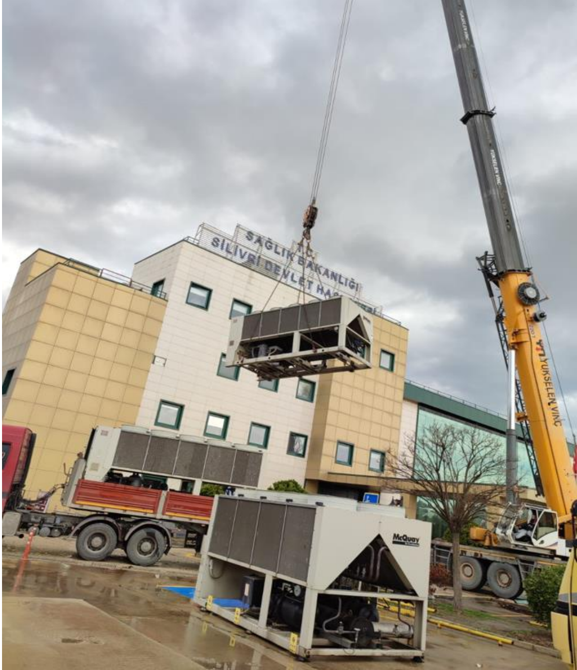
Fotoğraf 8. Mekanik Cihazların Mobil Vinç ile Çatıya Taşınması
