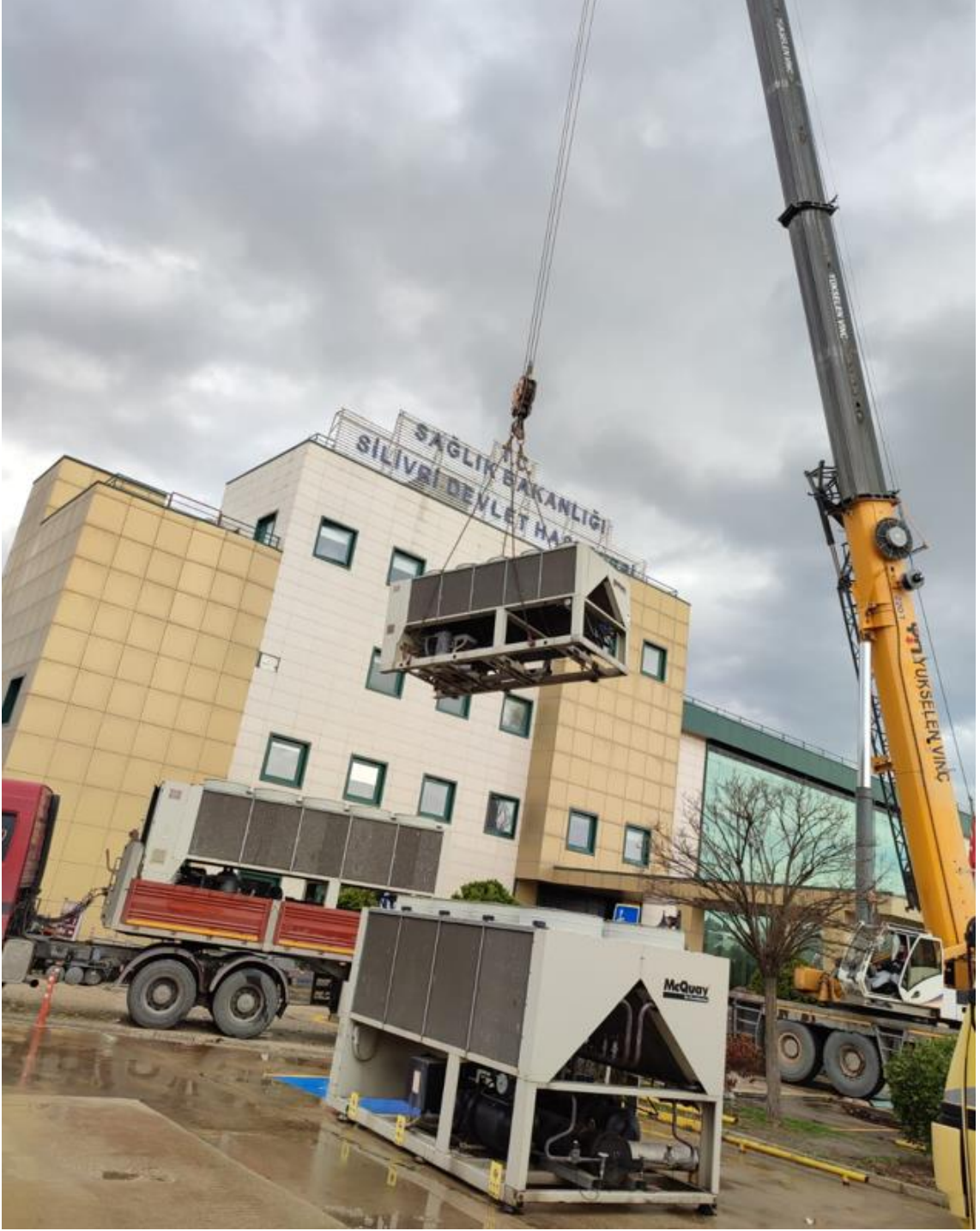
Fotoğraf 9. Mekanik Cihazların Mobil Vinç ile Çatıya Taşınması
