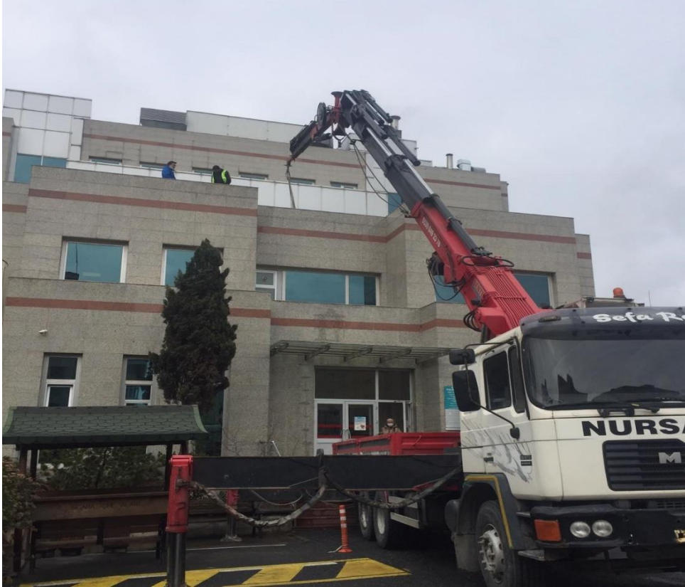
Fotoğraf 9. PV Panellerin Çatıya Taşınması-1
