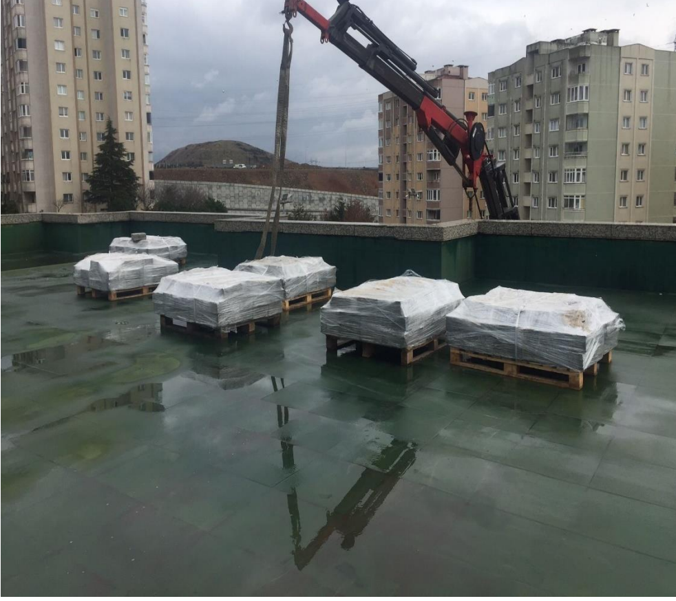
Fotoğraf 10. PV Panellerin Çatıya Taşınması
