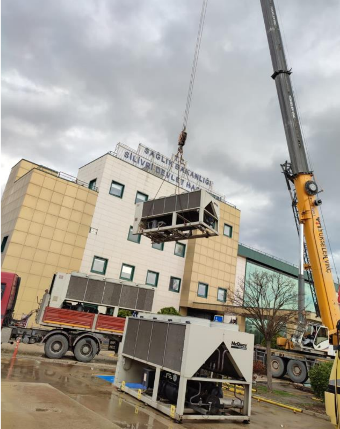
Fotoğraf 11. Mekanik Cihazların Mobil Vinç ile Çatıya Taşınması
