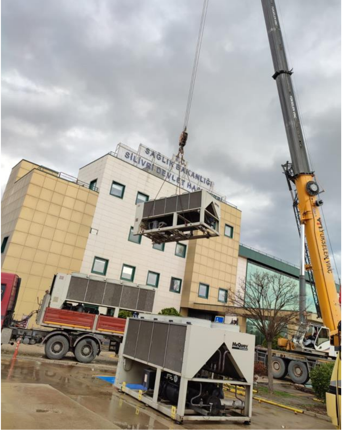
Fotoğraf 6. Mekanik Cihazların Mobil Vinç ile Çatıya Taşınması
