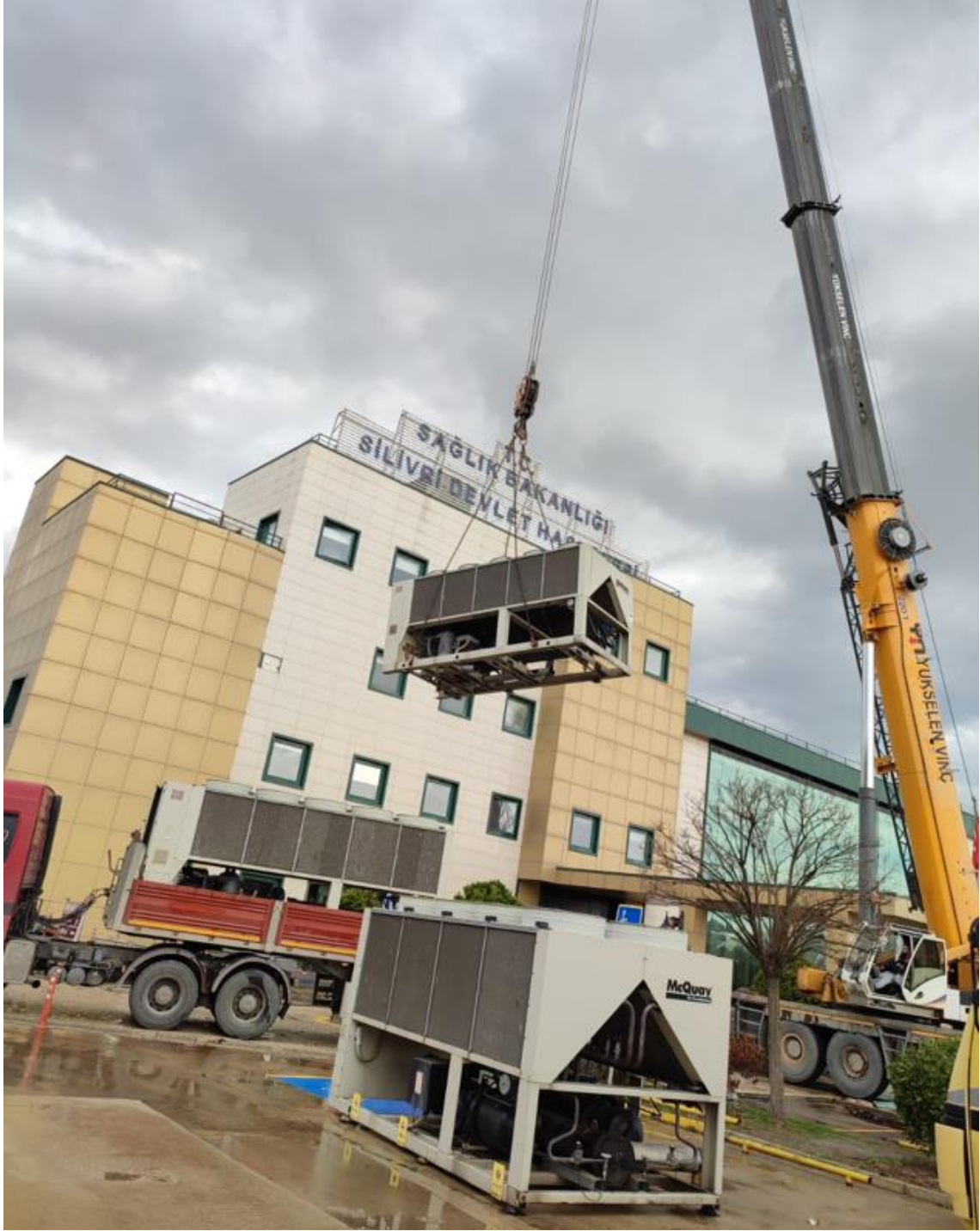
Fotoğraf 10. Mekanik Cihazların Mobil Vinç ile Çatıya Taşınması
