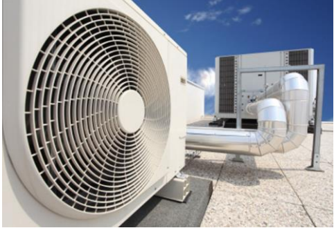
HVAC ve Otomasyon
